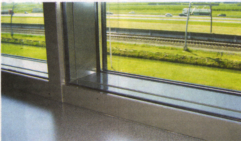
De geluidswerende gevel van binnenuit gezien.
